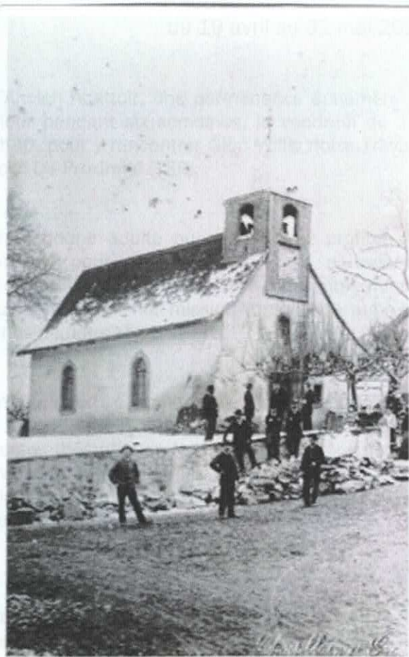
Ancienne église avant sa démolition en 1897
